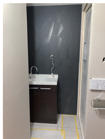
洗面台 (工事中)
